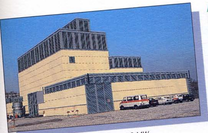
La centrale a Celle a combustibile da 1,3 MW
