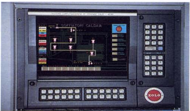
Terminale supervisore per sistema evoluto di comando "EOLO-ACDS"
